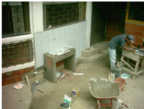
Der Bau des Wasserhahnes in der Schule
